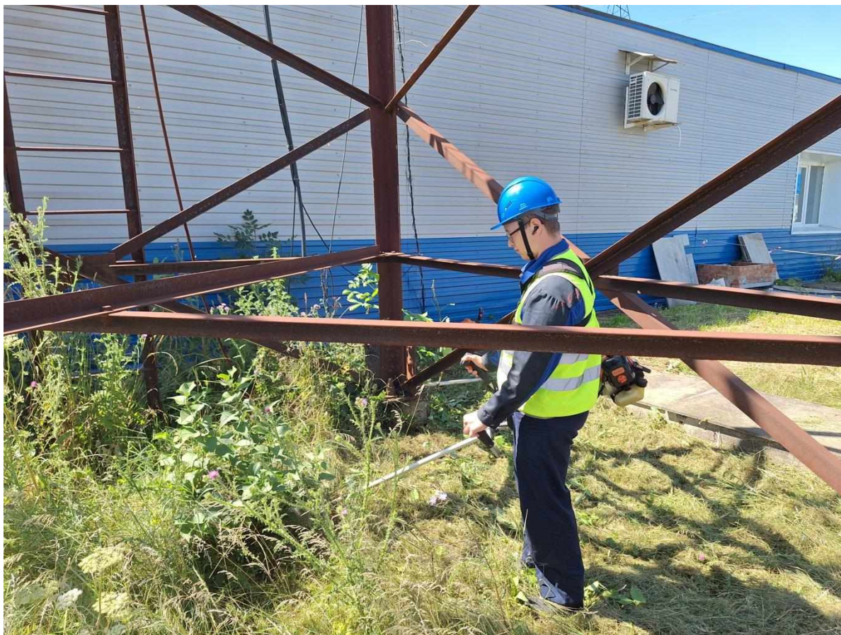
Рис.40. Отряд «Импульс». Уборка сорной растительности ВЛ 10/0,4 кВ.
